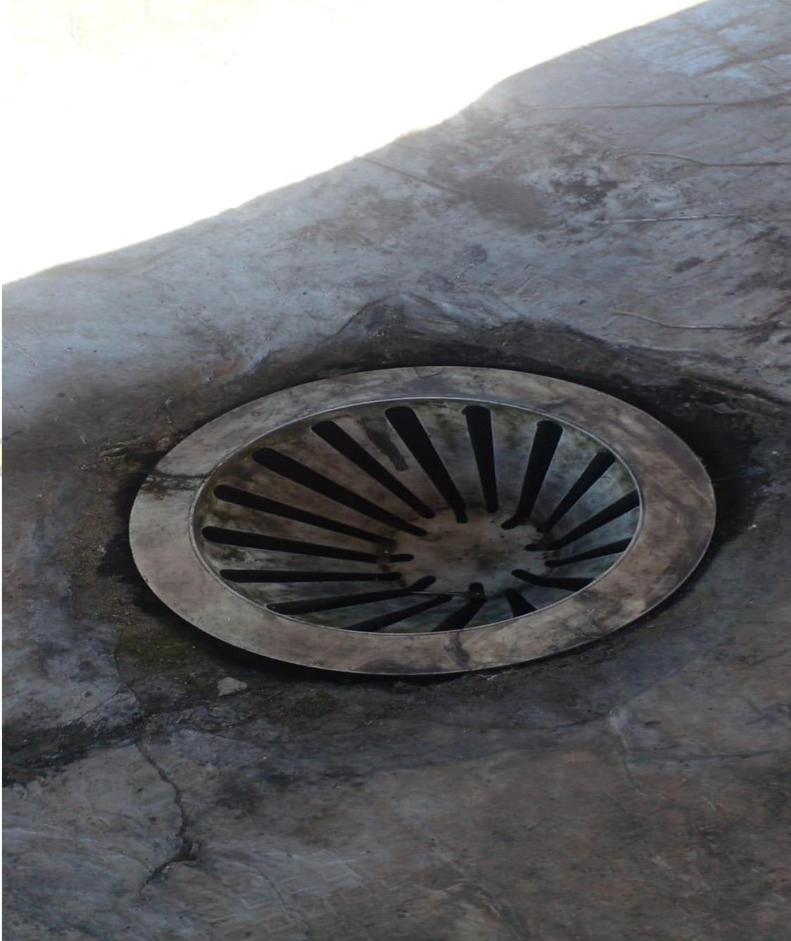
5. SE OBSERVA EL DETERIORO DE LA PINTURA BITUMINOSA DEL MANTO ASFALTICO CAUSADO POR EL ESTANCAMIENTO DE AGUA, NO HAY ESTANCAMIENTO DE AGUA DEBIDO AL BUEN CLIMA QUE HAY EN BOGOTA, SIN EMBARGO SE DEBE APROVECHAR PARA HACER LAS REPARACIONES ANTES QUE COMIENZE EL INVIERNO NUEVAMENTE.
